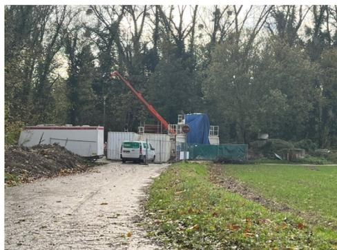
Les travaux de CANAMARNE qui obstruent le Chemin de La Rosée ont vu leur calendrier de réalisation très modifié. En effet, une prolongation des arrêts a été rendue nécessaire par suite d'une mauvaise estimation des fonçages à effectuer au passage de la Reneuse et du Canal de l'Ourcq et de plusieurs ennuis techniques.
