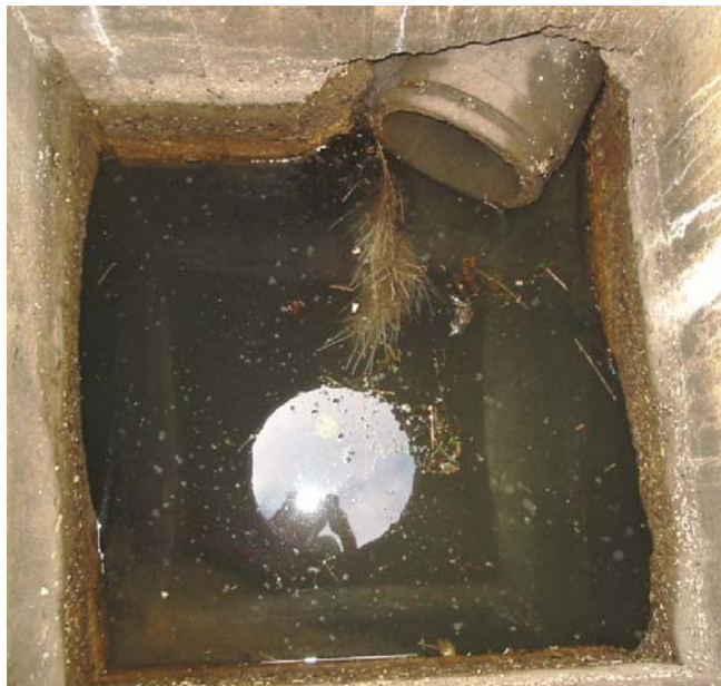
regard EP604 : trop-plein du dessableur vers un exutoire indéterminé en liaison avec la rivière
