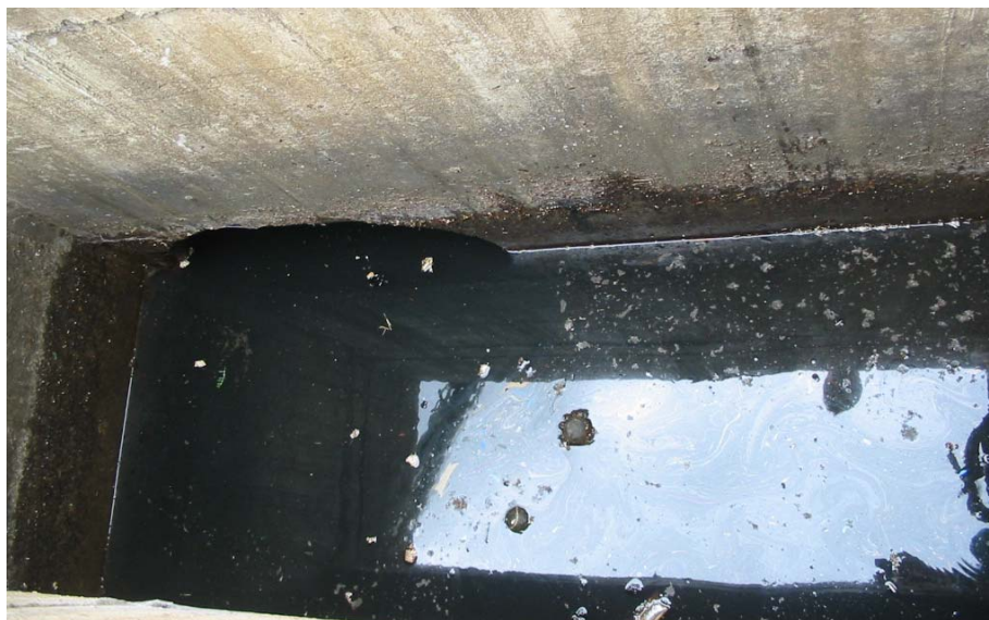
vue sur les effluents contenus dans la chambre de dessalement (traces d'hydrocarbures)
