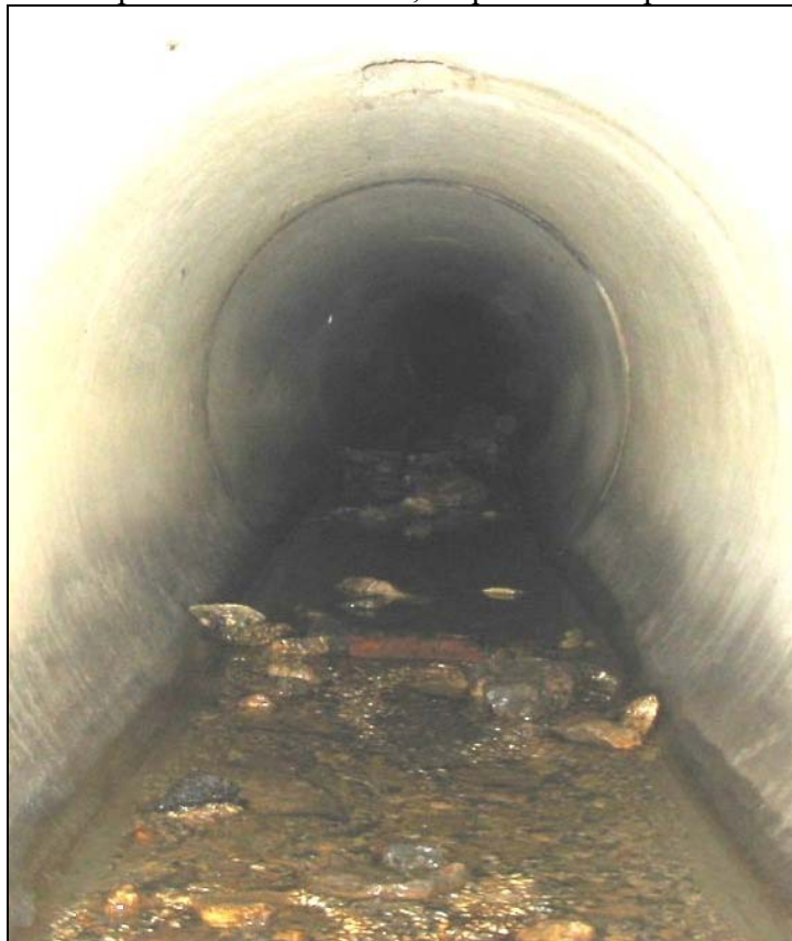
Gravats et pierres dans le Ø800, en partie curés par la SAUR :
