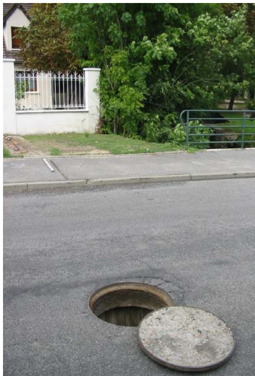
regard EP604 : trop-plein du dessableur vers un exutoire indéterminé en liaison avec la rivière
