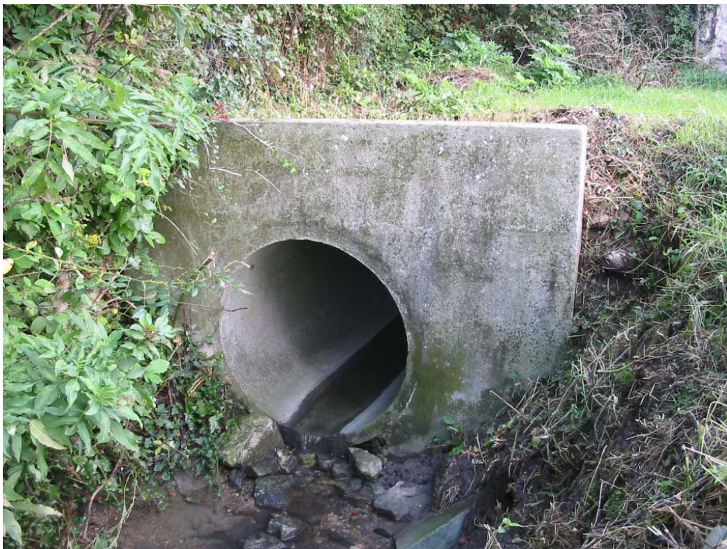
Vue de l'exutoire principal Ø1000 (EXU4) par temps sec :
