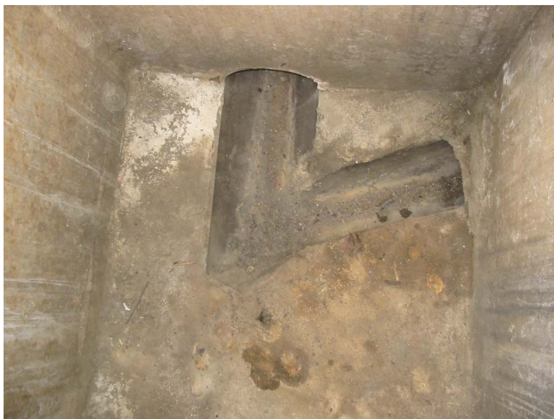
anomalie hydraulique + rétrécissement de section ( \varnothing 250 vers \varnothing 200 ) sur une antenne secondaire Rue Saint Denis
