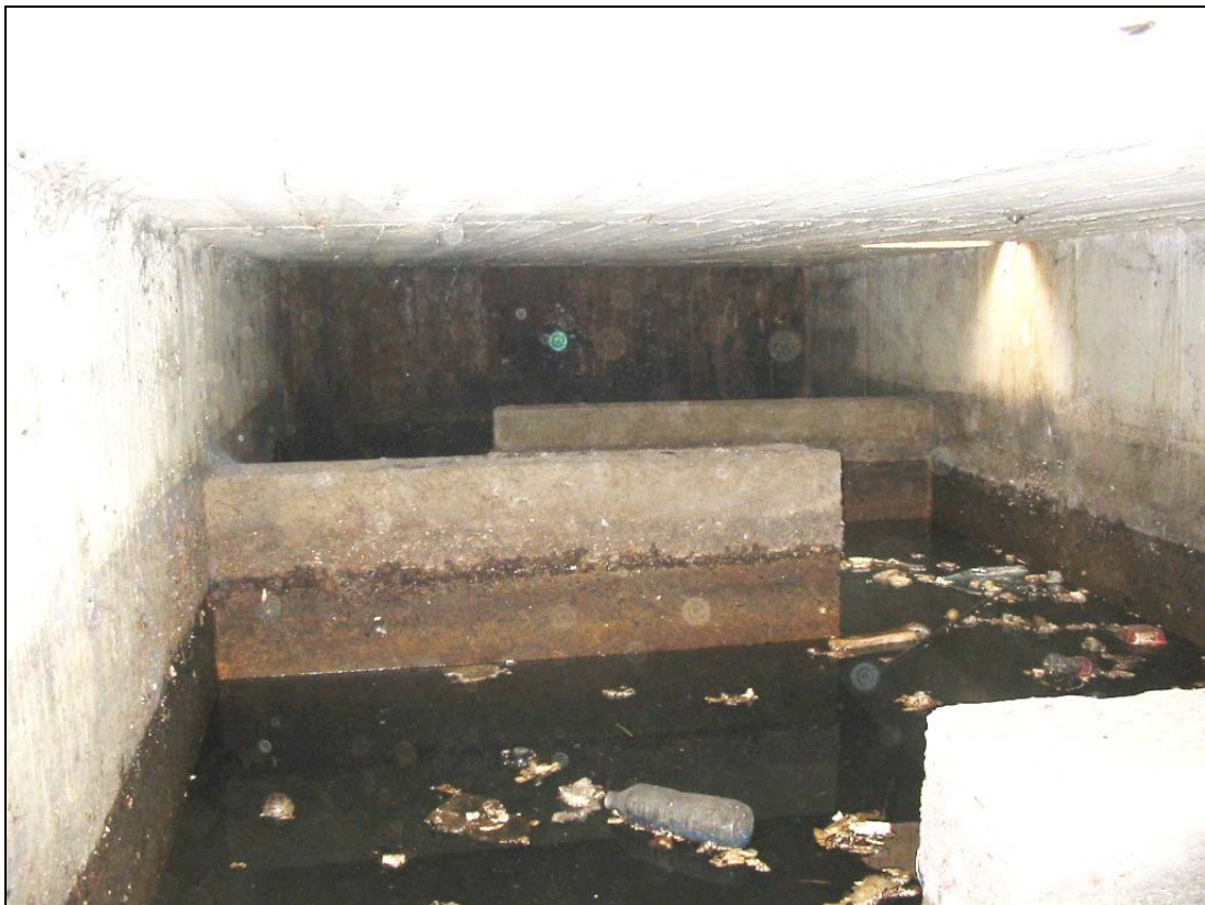
vue sur le dessableur (partiellement en charge) pendant intervention de la SAUR (19/08/08) vidange totale de l'ouvrage (et des dépôts) impossible en l'état
