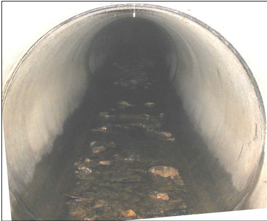
regard EP550 (amont) : léger encrassement (12/09/08)
