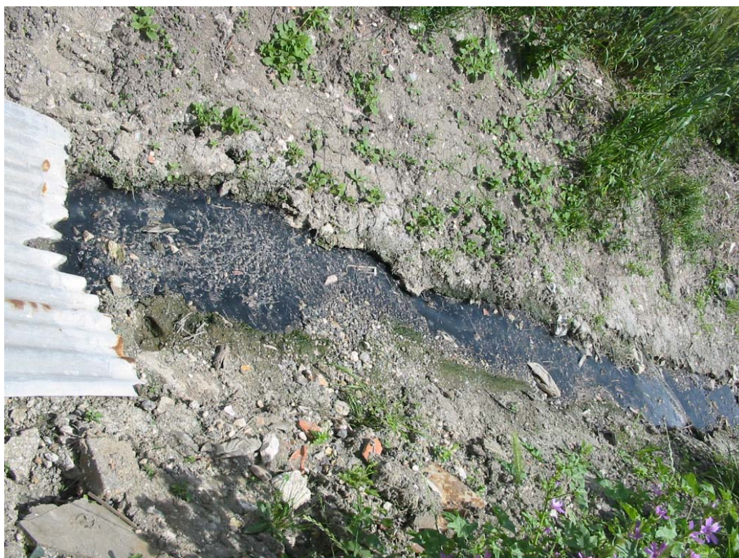
écoulement d'effluents septiques dans le fossé
