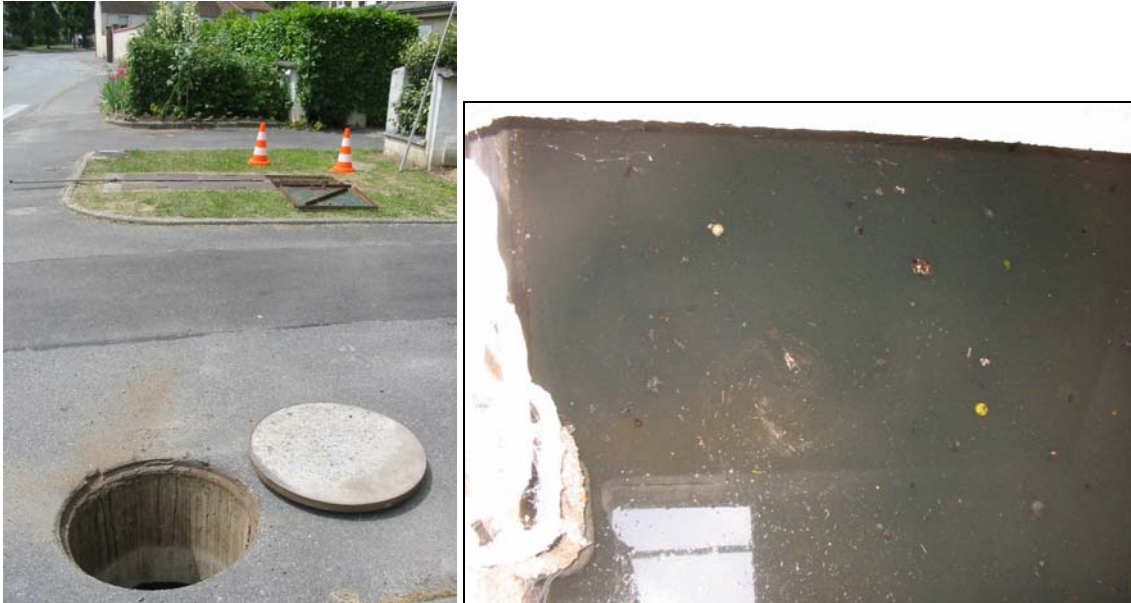
accès à la chambre de dessablement (en charge)
