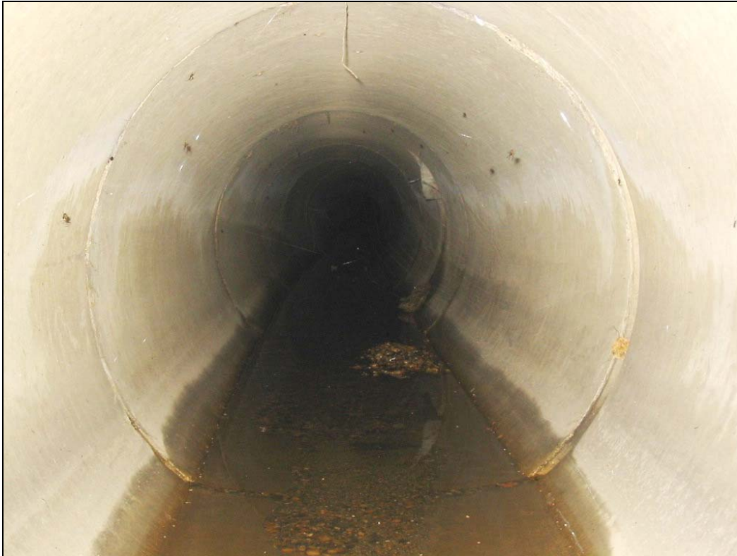
Légers dépôts dans le Ø1000 route de Claye-Souilly :
