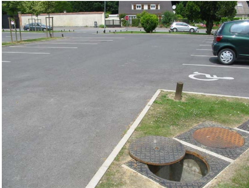
vue sur le séparateur à hydrocarbures situé sur le parking de la Mairie / Ecole
